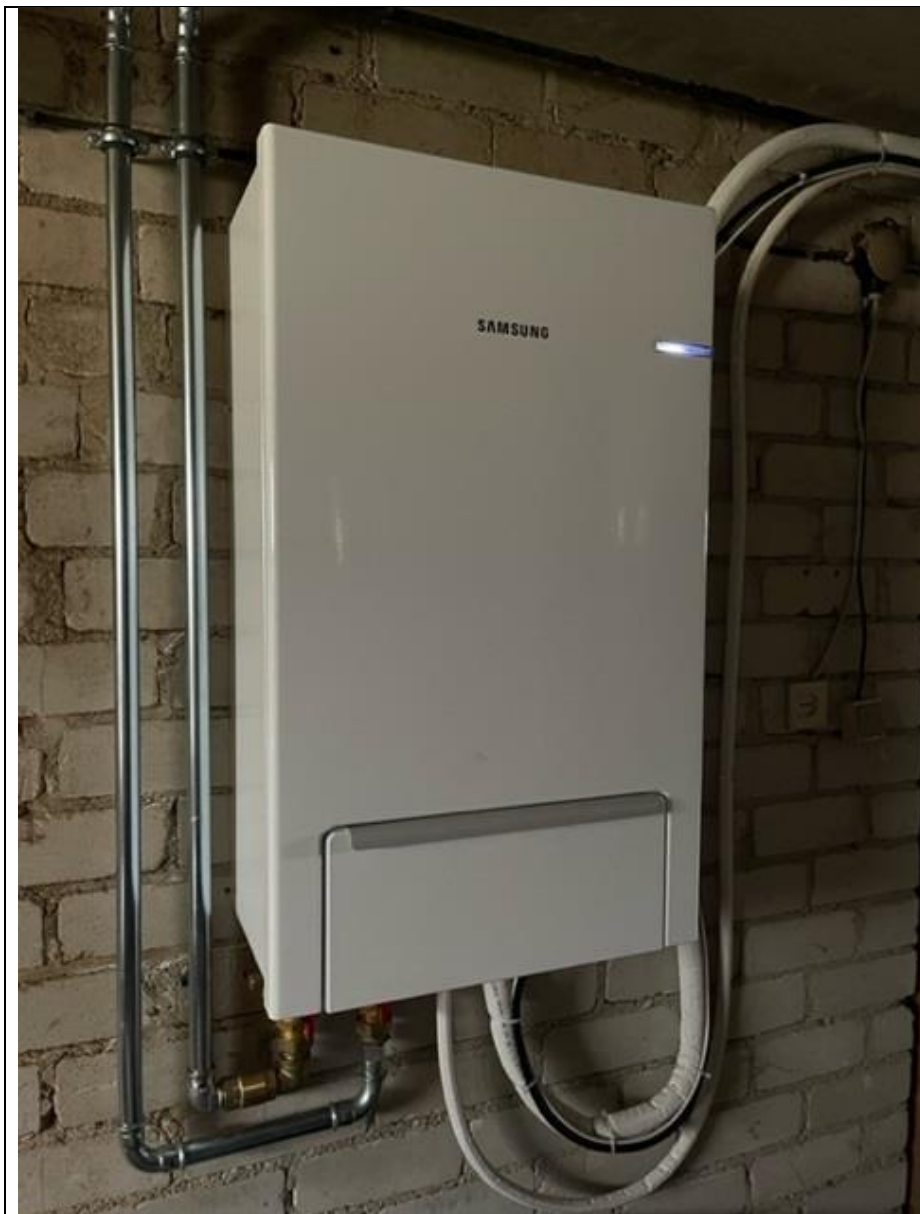
Pav. 5. Šilumos siurblio oras – vanduo vidinis modulis.
