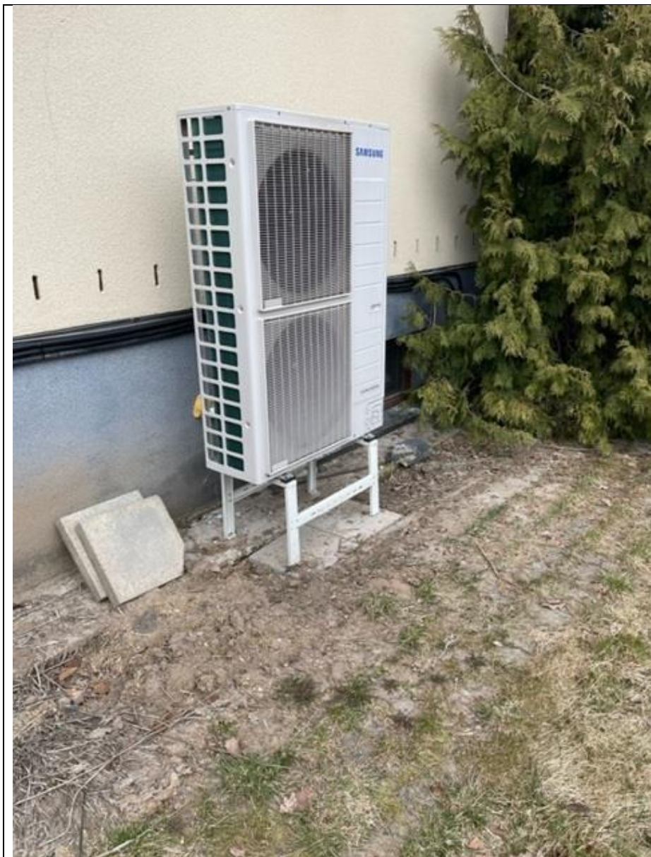
Pav. 4. Šilumos siurblio oras – vanduo išorinis modulis.
